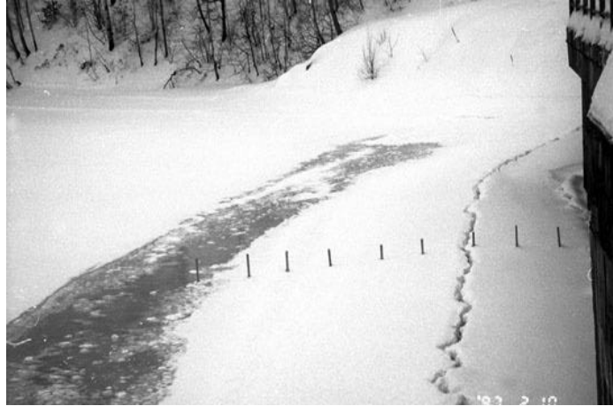
Photo 1.: Hiver 1997, Instabilité latérale du champ de glace, Barrage de Shawinigan.
