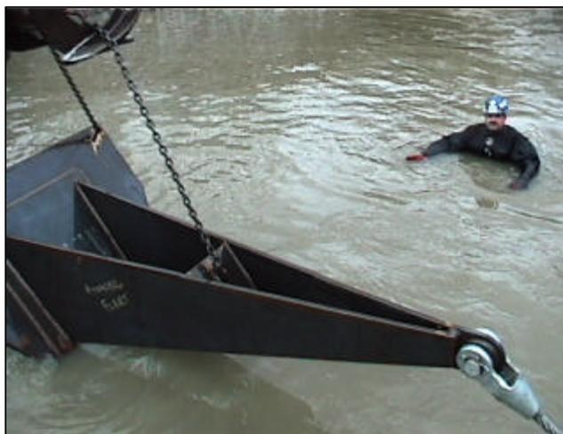
Figure 3: Installation of «Stevin» Anchor.
